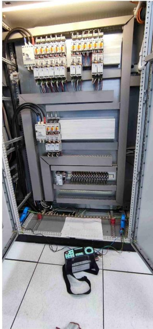
Proyecto /QUIMETAL – MEDICIÓN RESISTENCIA DENTRO SALA ELÉCTRICA BAJA TENSIÓN TRANSFORMADOR 5
